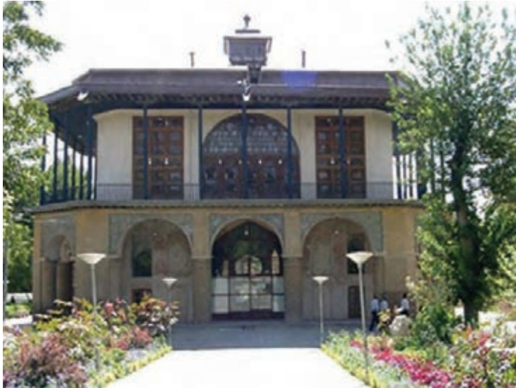
▲ شکل ۸-۱۲- عمارت چهلستون، قزوین
