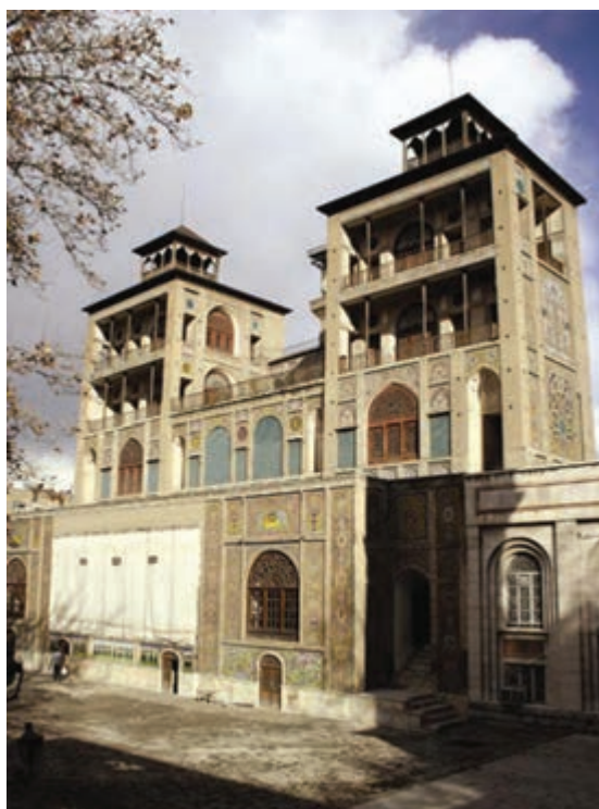
▲ شکل ۹-۱۳- شمس‌العماره، عمارت قاجاری، تهران
